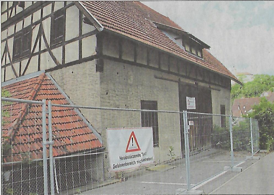
Schilder signalisieren Gefahr bei der Stallscheune in der Friedrichstraße.
