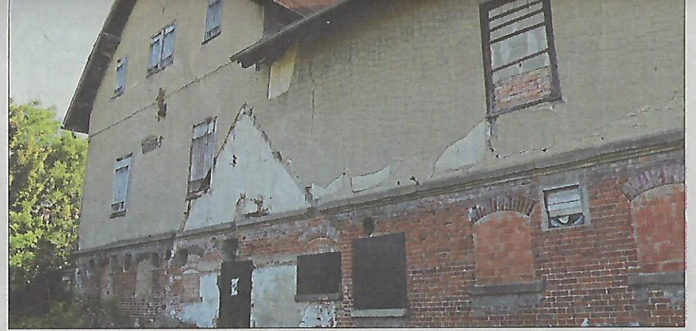
Die Stallscheune von Westen aus gesehen.
