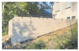
Fundamente einer Kranbahn, die am Bahnradweg beginnen und das später aufgesetzte Kleintierzüchterheim tragen. Allerdings war der Zustand des Betons dieser Fundamente vor einigen Jahren besorgniserregend: Überall Risse, eindringender Bewuchs, Versinterung. Nach Anregung von Reinhard Wahl hat die Stadt eine professionelle Restaurierung durchführen lassen – vorbildlich bezuschusst vom Landesamt für Denkmalpflege.
